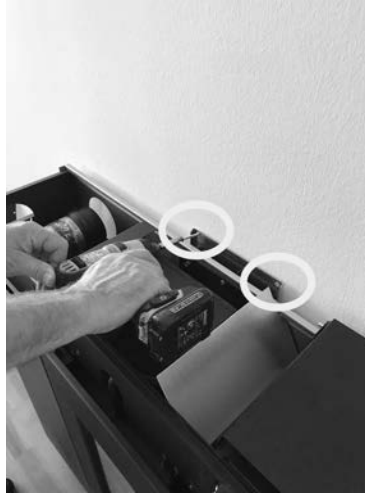
Fig. 26 - Fijación en pared
